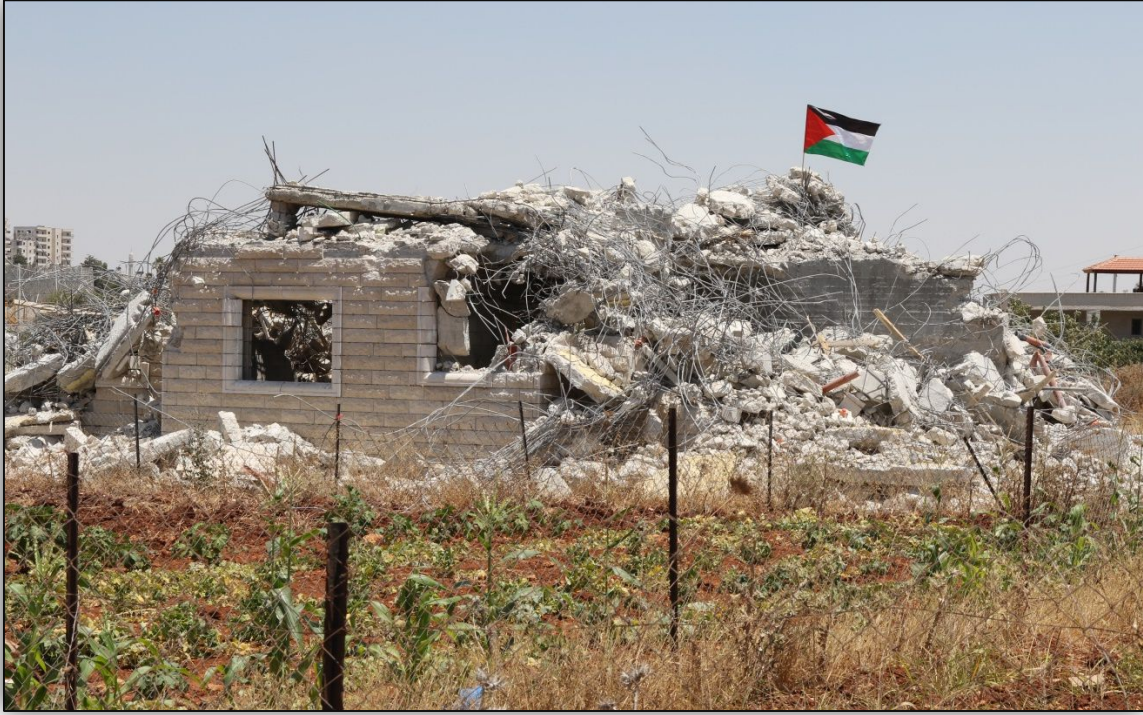
صورة (6): توضح عملية هدم في منطقة الزعيم بمحافظة القدس
