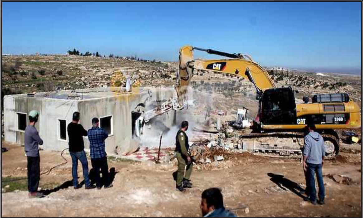
صورة (6) : توضح عملية هدم احد المنازل في الخليل
